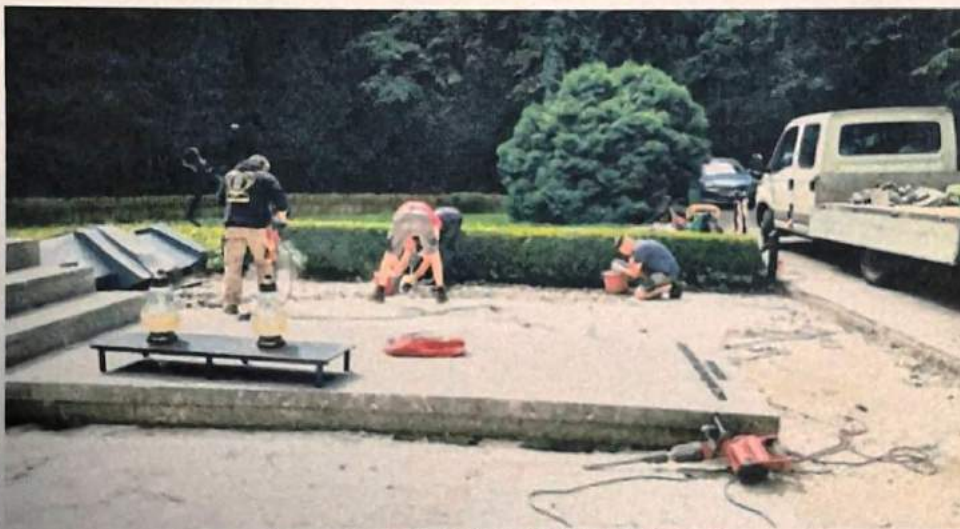
W ubiegłym tygodniu rozpoczęto prace przy wymianie płyt we frontowej części pomnika.
